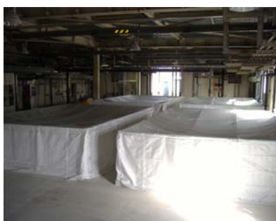
写真-5 安全手摺及び防臭シート
