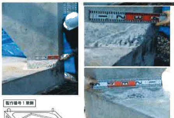
第1回打設で不具合が発生。柱下端に充填不足（豆板）が見られます。軽微なものには見えますが、担当者個人の判断によらず、不具合はすべて第三者で情報を共有することが大切です。
